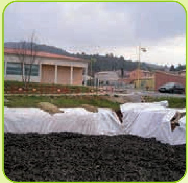
Instalación de geomembrana
