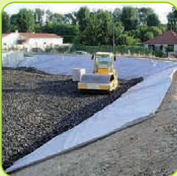
Colocación de Draingom y apisonamiento
