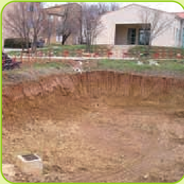
Excavación y colocación
