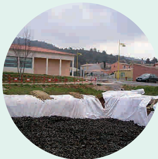
Instalación de geomembrana
