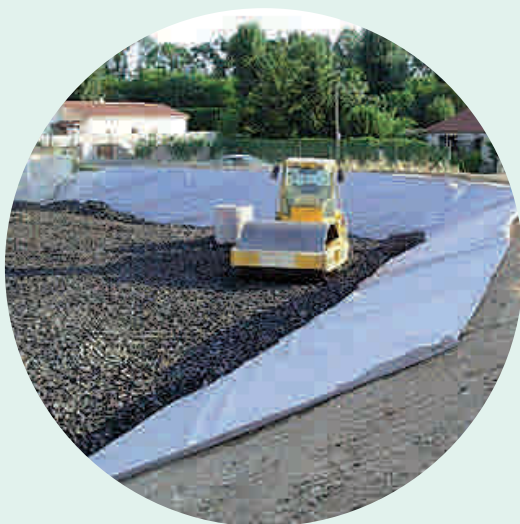
Colocación de Draingom y apisonamiento
