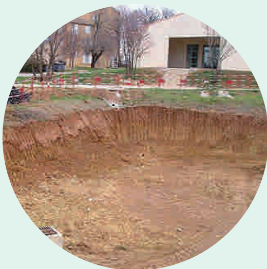
Excavación y colocación
